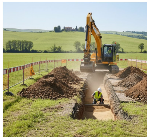
Figura 11 - pulizia del fondo ed installazione del letto di posa
