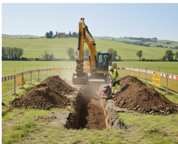
Figura 14 - rinterro con costipazione
